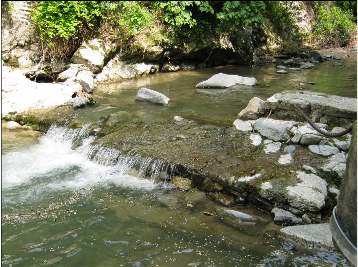
Figura 4– Briglia in lastre di pietra gravemente dissestata da ripristinare
