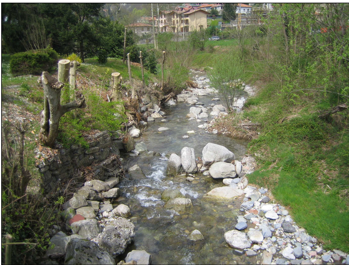
Figura 7– gabbioni in sinistra che verranno demoliti e sostituiti da difesa spondale
