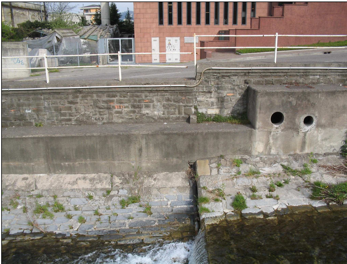
Figura 6– Muro di sponda da riportare in quota a garanzia del franco idraulico(Sez. n. 45)
