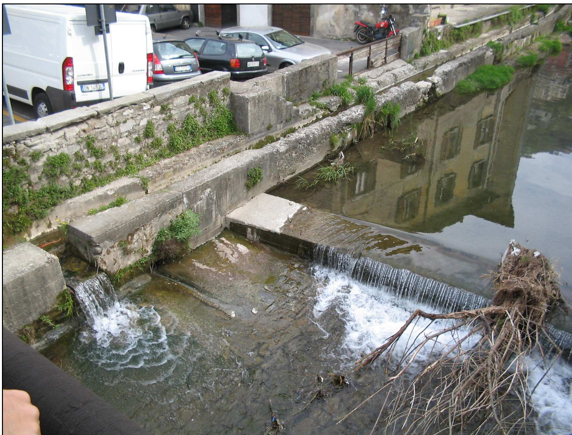
Figura 5– Muro di sponda destra da riportare in quota a garanzia del franco idraulico(a monte sez. n. 42)
