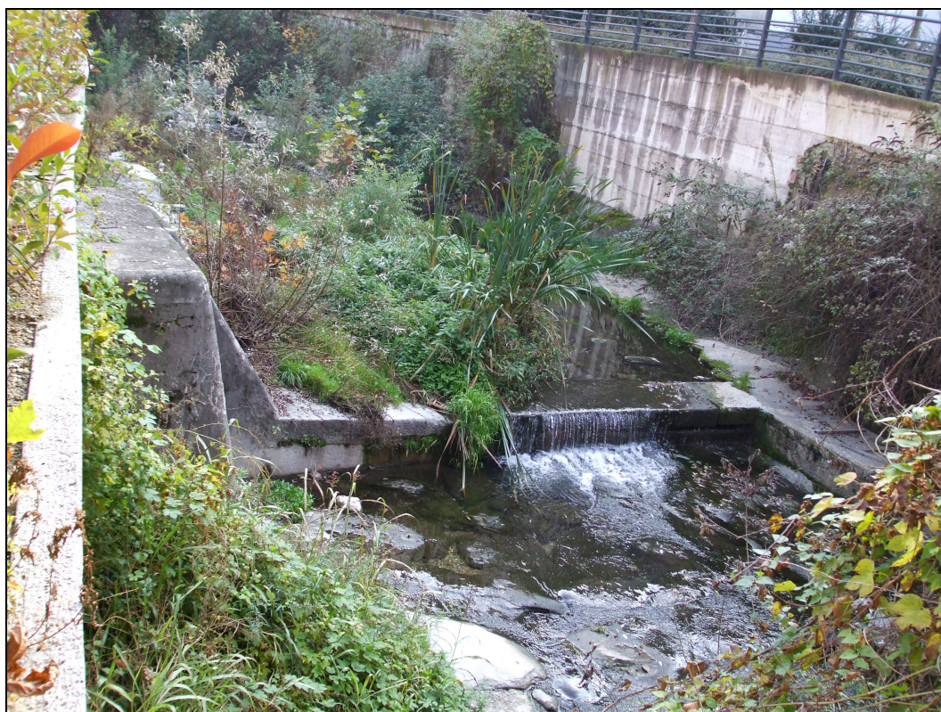
Figura 10– Materiale da movimentare al fine di garantire una migliore ufficiosità dell'alveo
